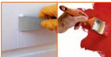
Когда шпатлёвка высохнет, стыки следует отшлифовать шкуркой. После того как все места стыковки панелей утепления, лепного декора и крепления дюбелей высохли и зашлифованы, панели легко грунтуются водной грунтовкой и красятся силиконовыми или акриловыми фасадными красками на водной основе (краски не должны содержать растворитель или ацетон).
