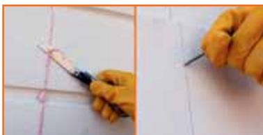
В местах соединения панелей макетным ножом срежьте излишки высохшей пены, слева и справа необходимо вырезать фаску глубиной от 2 до 5 мм. Затем эти швы-стыки зашпаклюйте шпатлёвкой PS-TechnoPlaster, как и отверстия от дюбелей. После высыхания шпатлёвки эти места шлифуются тонкой шкуркой. Соединения панелей утепления и лепного декора также необходимо зашпаклевать.
