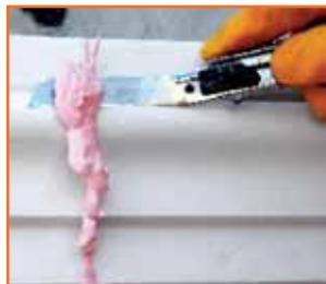
Макетным ножом срежьте излишки высохшего клея и в месте соединения справа и слева под углом сделайте фаску глубиной 2–5 мм. Заполните канал с помощью эластичной шпатлёвки PS-TechnoPlaster. После высыхания шпатлёвки стыки нужно отшлифовать.
