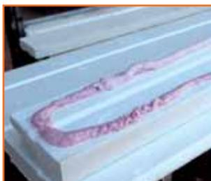
Обратную сторону элемента LEPNINAPLAST нужно обработать с помощью гребенки клеевым составом **Ceresit (CT 83 или CT 85)** либо другим аналогичным составом.
