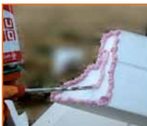
Между деталями необходимо оставлять зазоры шириной от 2 до 5 мм. Для склеивания деталей между собой рекомендуется использовать полиуретановый клей (**Ceresit CT 84, PENOSIL Fix&Go Montage** или **TYTAN Styro 753**).
